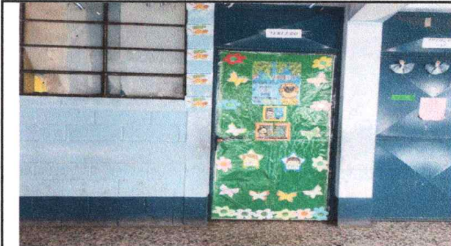
Foto 6: SUSTITUCION DE PUERTA DE METAL EN AULA NUMERO 10.
