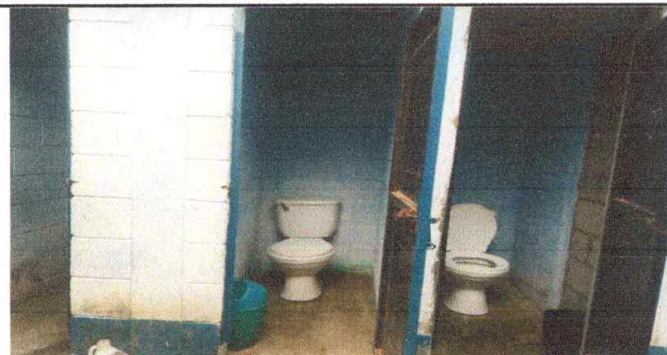
Foto 13: SUSTITUCION DE AZULEJOS EN SANITARIOS.
