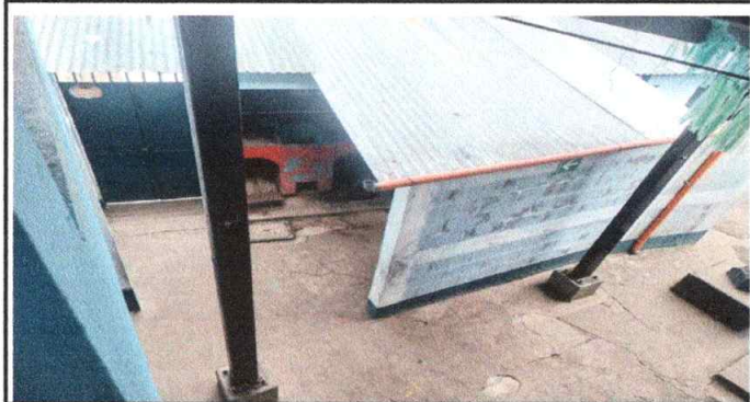
Foto 5: SUSTITUCION DE ESTRUCTURA DE TECHO . ESTRUCTURA DE SOPORTE DE MADERA, POR METAL. EN EL AREA DE LA PILA Y SALIDA DE EMERGENCIA.
