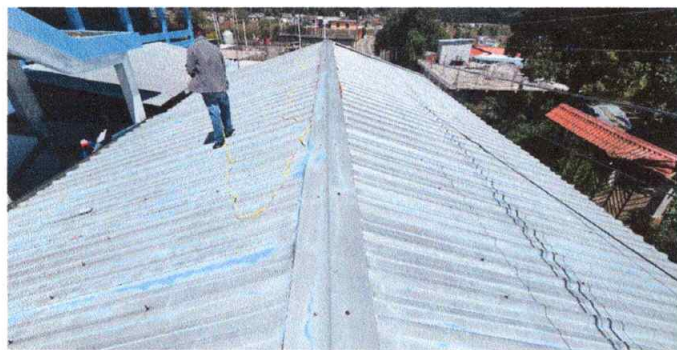
Foto 3: SUSTITUCION DE LAMINA POR LAMINAS TROQUELADAS DE ALUZINC CALIBRE 26 MAXALUM C26(0.40mm) E25 G80 AZM150 MDA. EN AULAS NUMERO 2 Y 3.
