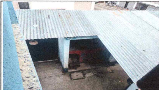
Foto 2: SUSTITUCION DE LAMINA POR LAMINAS TROQUELADAS DE ALUZINC CALIBRE 26 MAXALUM C26(0.40mm) E25 G80 AZM150 MDA. EN EL AREA DE LA PILA Y SALIDA DE EMERGENCIA.
