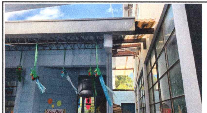
Foto 10: INSTALACION DE CANALES DE METAL
