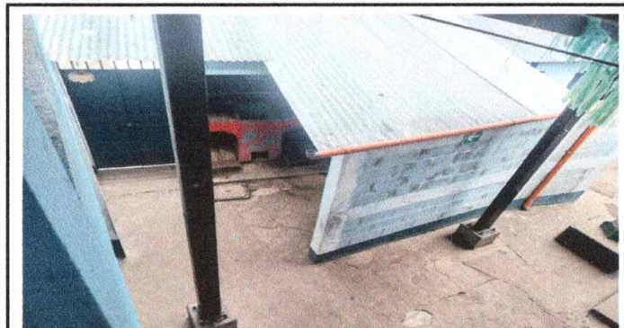
Foto 11: SUSTITUCION DE TUBERIA PARA BAJADA DE AGUA PLUVIAL.
