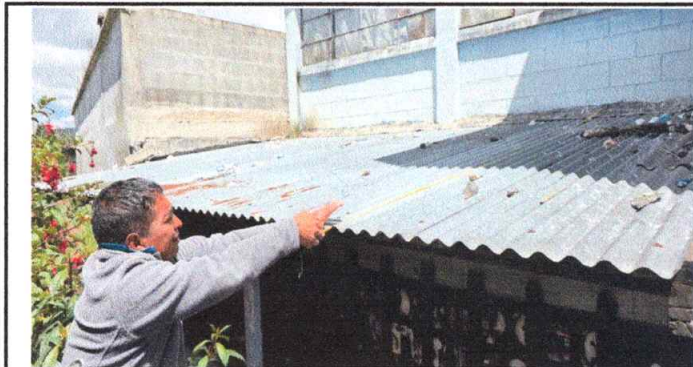
Foto 1: TECHADO CON LAMINAS TROQUELADAS DE ALUZINC CALIBRE 26 MAXALUM C26(0.40mm) E25 G80 AZM150 MDA. EN AULA NUMERO 4.
