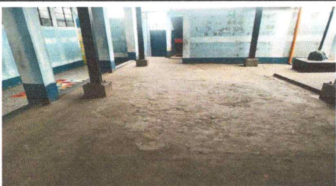
Foto 15: REPARACION DE PLANCHAS DE CONCRETO EN PATIO.
