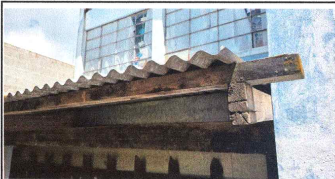
Foto 4: SUSTITUCION DE ESTRUCTURA DE TECHO EN AULA NUMERO 4. ESTRUCTURA DE SOPORTE DE MADERA, POR METAL.
