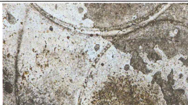
Foto 14: REPELLO MAS CERNIDO EN MURO EXTERIOR DE AULA NUMERO 9.
