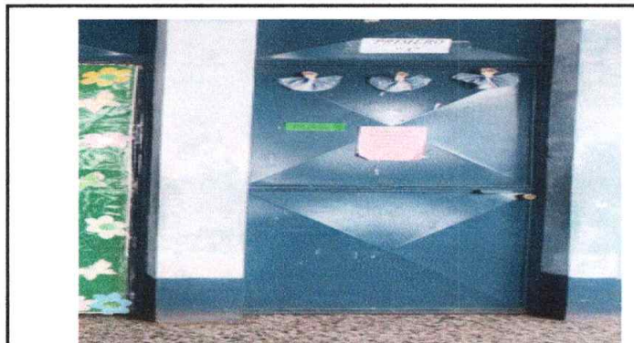
Foto 9: SUSTITUCION DE CHAPA EN PUERTA DEL AULA NUMERO 9.
