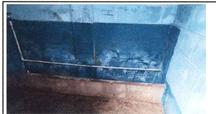
Foto 12: REPARACION DE MINGITORIO.
