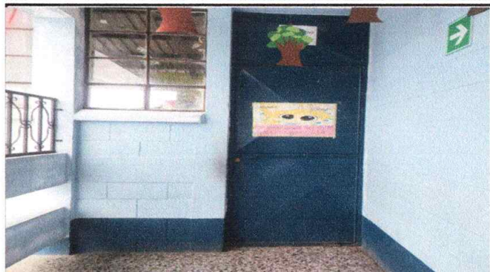
Foto 8: SUSTITUCION DE PUERTAS DE METAL EN AULA NUMERO 12.
